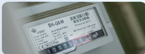
Installazione sistemi di misura
